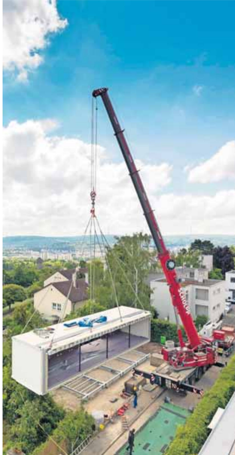
Mobil und sparsam: Das „Aktivhaus“ von Schwörer Haus erzeugt Energie aus erneuerbaren Quellen (oben). Die Modulbauweise eignet sich auch für Kitas wie zum Beispiel in Olching bei München (unten). Das Haus von Algeco wurde innerhalb von acht Wochen aufgestellt.
