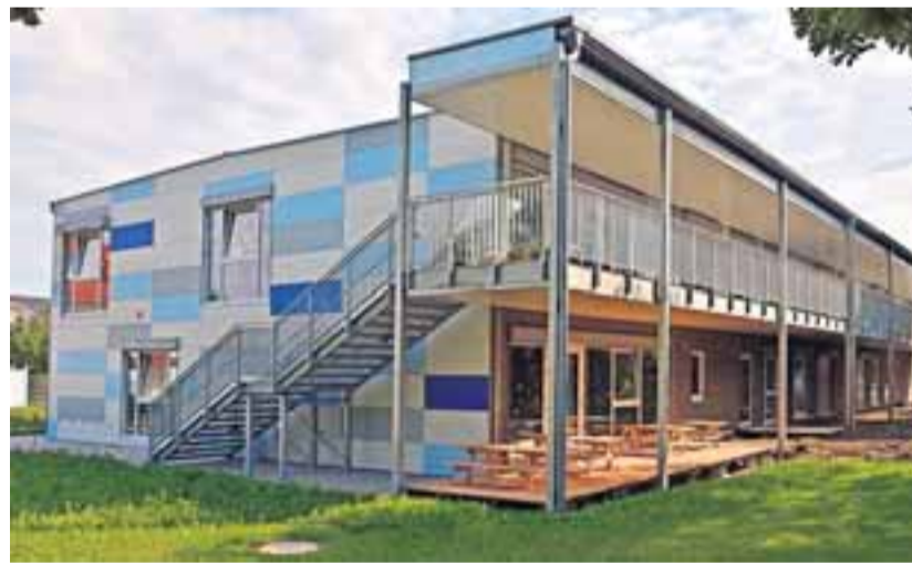
Mobil und sparsam: Das „Aktivhaus“ von Schwörer Haus erzeugt Energie aus erneuerbaren Quellen (oben). Die Modulbauweise eignet sich auch für Kitas wie zum Beispiel in Olching bei München (unten). Das Haus von Algeco wurde innerhalb von acht Wochen aufgestellt.
